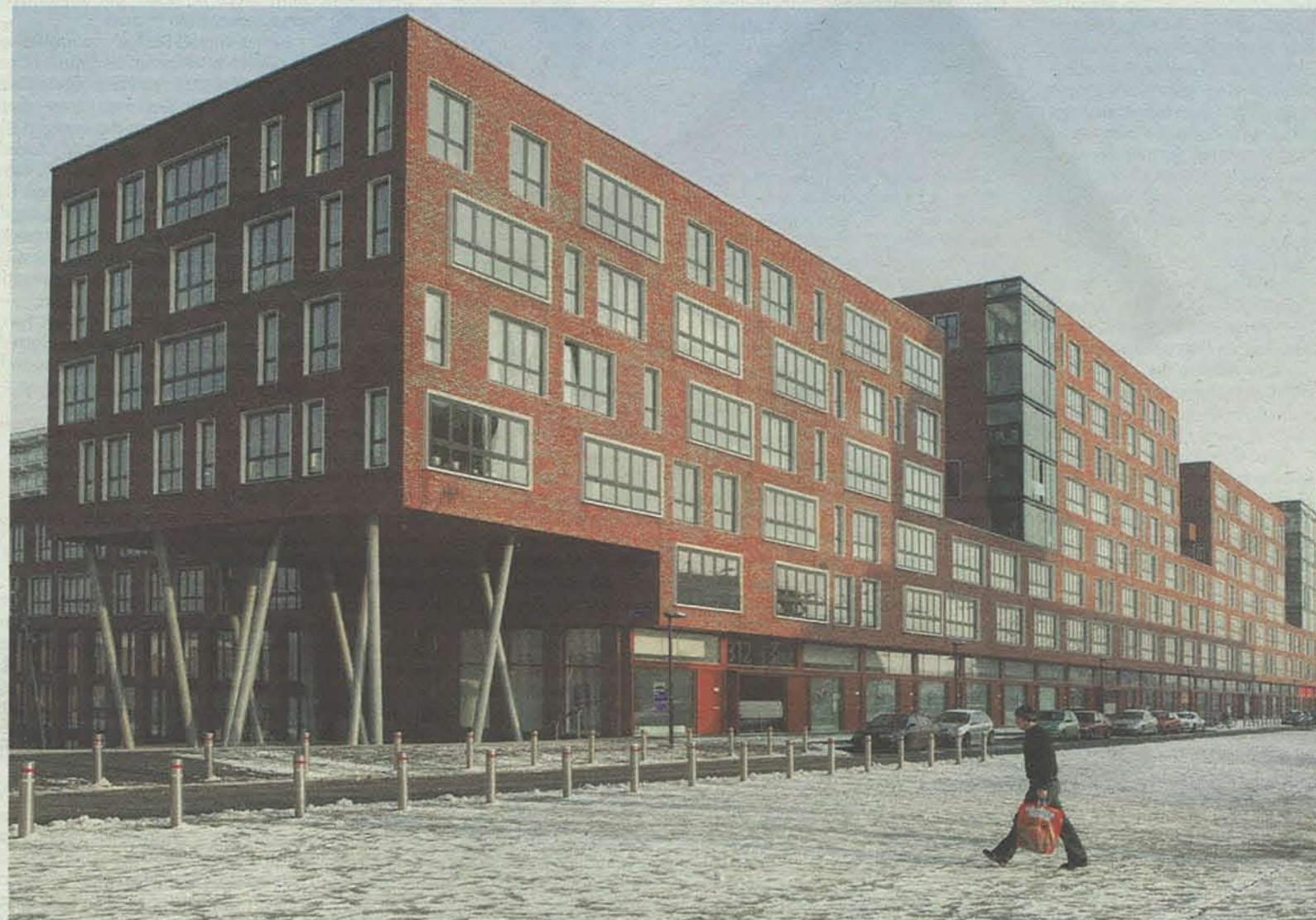
Nieuwbouwcomplex Fenice aan de Bijlmerdreef, in het centrum van Amsterdam Zuidoost.
